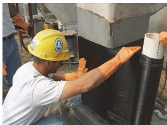
Рис. 2. Фрагмент виконання робіт з підсилення колон вуглеволокном
