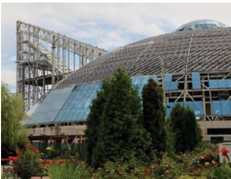
Рис. 4. Конструкції купола на стадії монтажу покриття
