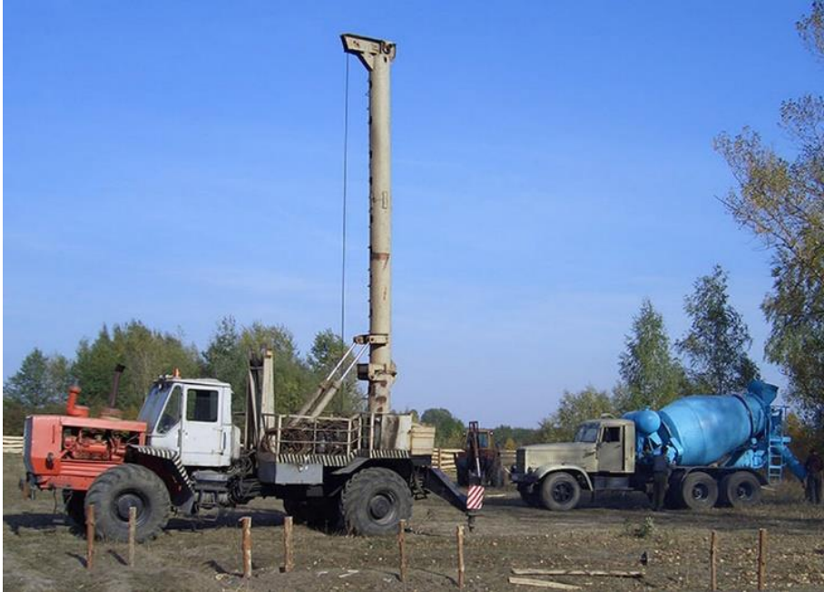
Рис. 1. Мобільне обладнання для влаштування НППС
