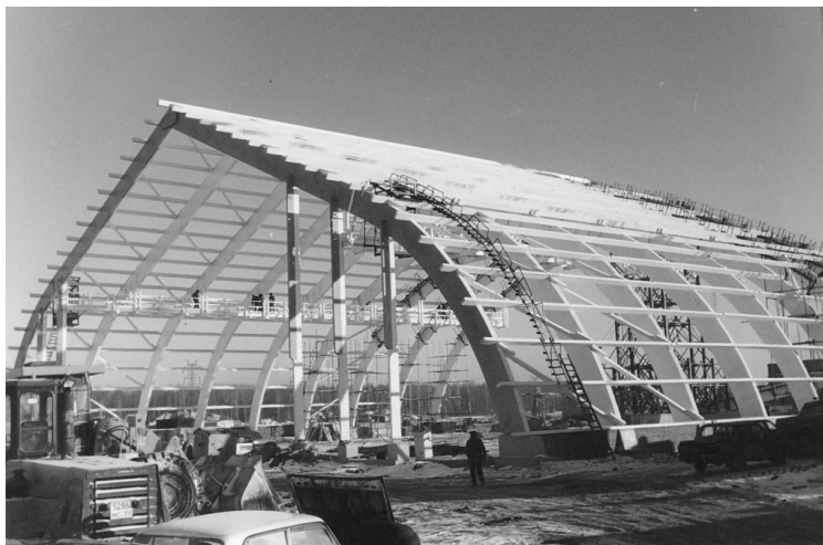
Рис. 9 Покриття універсального спортивного стадіону. Двохшарнірні арки з клеєної деревини прольотом 100 м м. Ванкувер. Канада, 2008 р.
