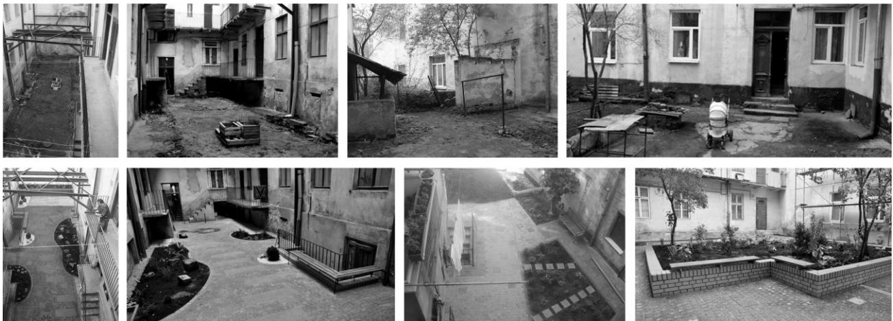
Рис. 3. Львівські дворики (вул. Газова, 6, вул. Дрогобича, 10, вул. Кониського, 3-5)
