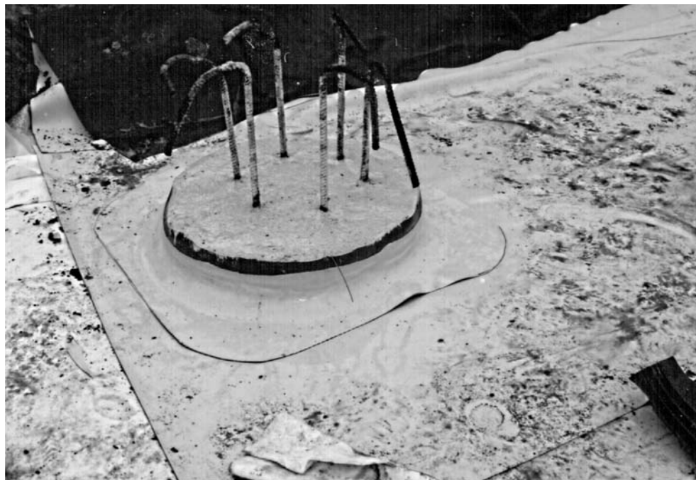
Рисунок 3 - Усиление гидроизоляции в месте примыкания к бетонной свае
