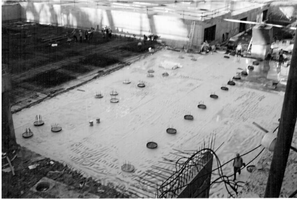
Рисунок 1 - Внешний вид гидроизоляции днища
