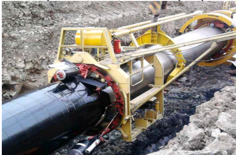
Рисунок 1. Агрегат ізоляційний роторний типу МИР для нанесення на зовнішню поверхню трубопроводу захисних стрічкових полімерних матеріалів з одночасним прикочуванням внутрішніх шарів покриття.
