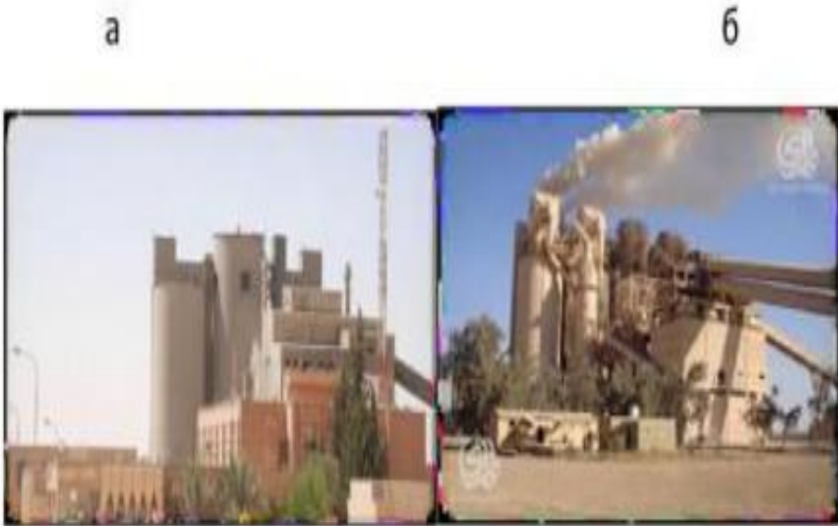
Рис.1.Цементные заводы Аль-Каим(а) и Кубайса(б).
