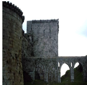
Рис.1. Приклади пошкоджень конструкцій фортеці Аль-Хосн в результаті нерівномірного осідання основ: а - тріщини в підвалах галерей; б – розрушення каменів арки в південній частині фортеці; в - відділення кута кріпосної стіни південної частини
