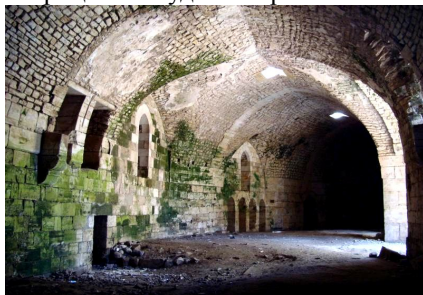
Рис.3. Кам'яні склепіння великого залу фортеці Аль-Хосн що руйнуються в результаті просочування води
