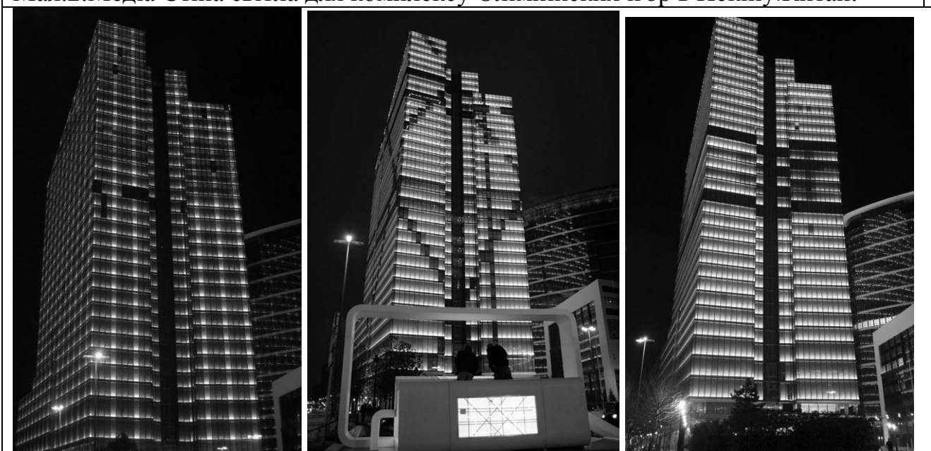
Мал.3. Світлодіодний фасад будівлі Dexia Tower в Брюсселю. Бельгія.
