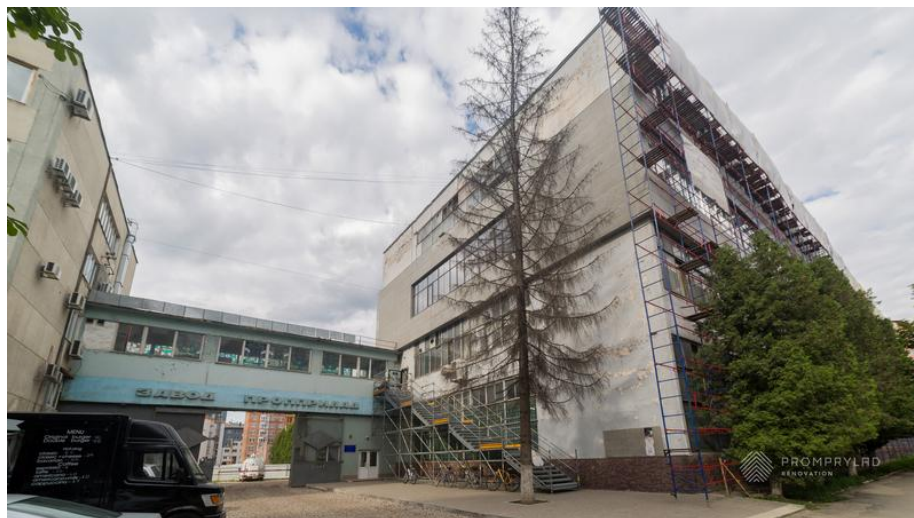
Рис. 1. Загальний вигляд ревіталізованого заводу “Промприлад” в м.Івано-Франківську. https://warm.if.ua/projects/promprylad
