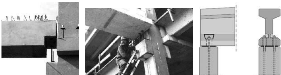
Рис. 2. Варіанти спирання балок на колони
