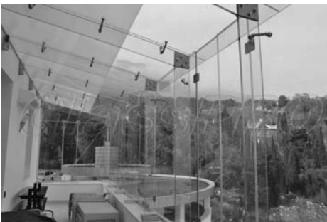
Рис. 4. Кріплення спайдера скляних ребер
