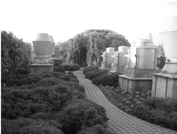
Рис. 5 Сад на крыше библиотеки Варшавского университета (Польша)
