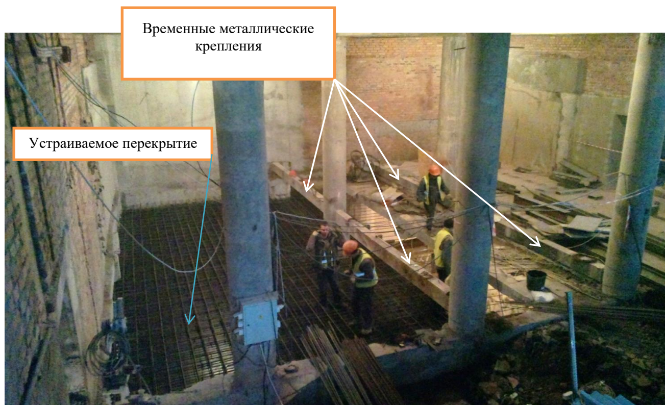
Рис.4. Замена конструкций перекрытия
