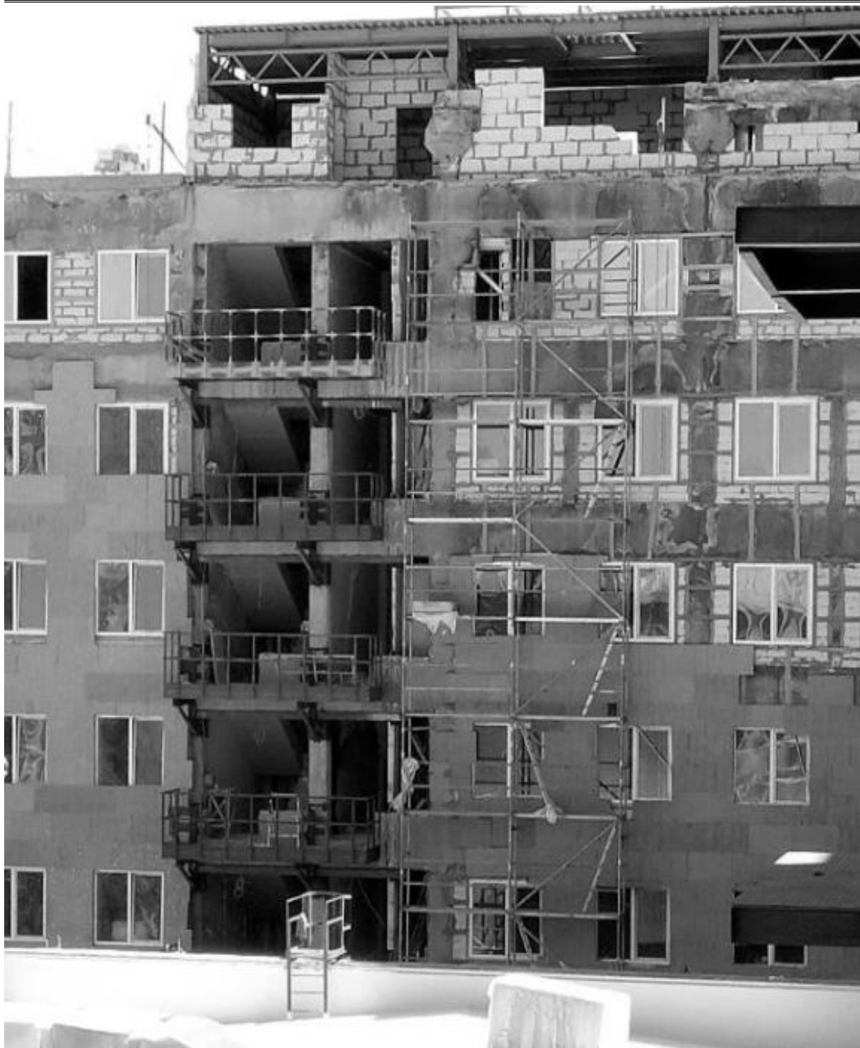
Рис. 4. Фрагмент стены фасада реконструируемого здания в осях «М-К».
