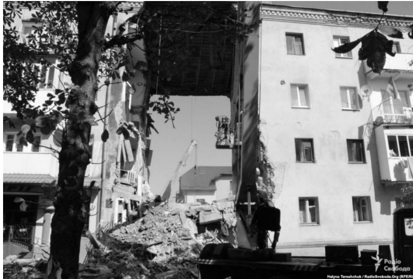
Рис. 4. Обрушення частини житлового будинку в м. Дрогобич (2019)
