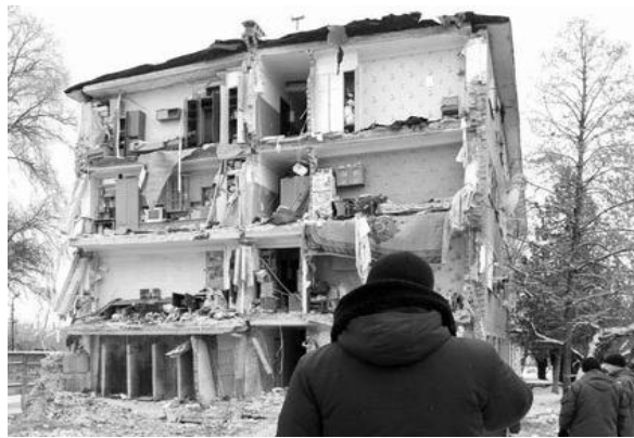
Рис. 2. Вид будівлі в м. Чернігів після демонтажу торцевої частини
