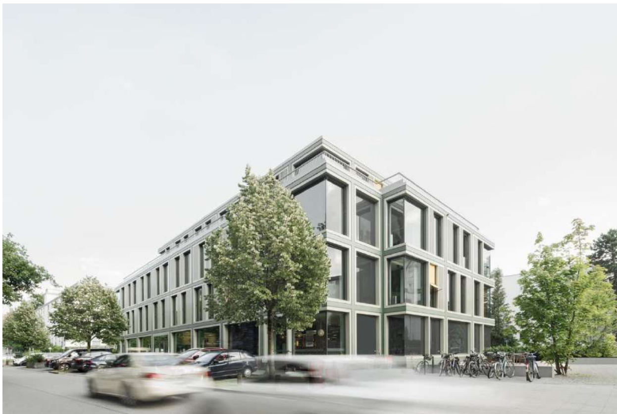
Рис. 2.1 Загальний вид будівлі
