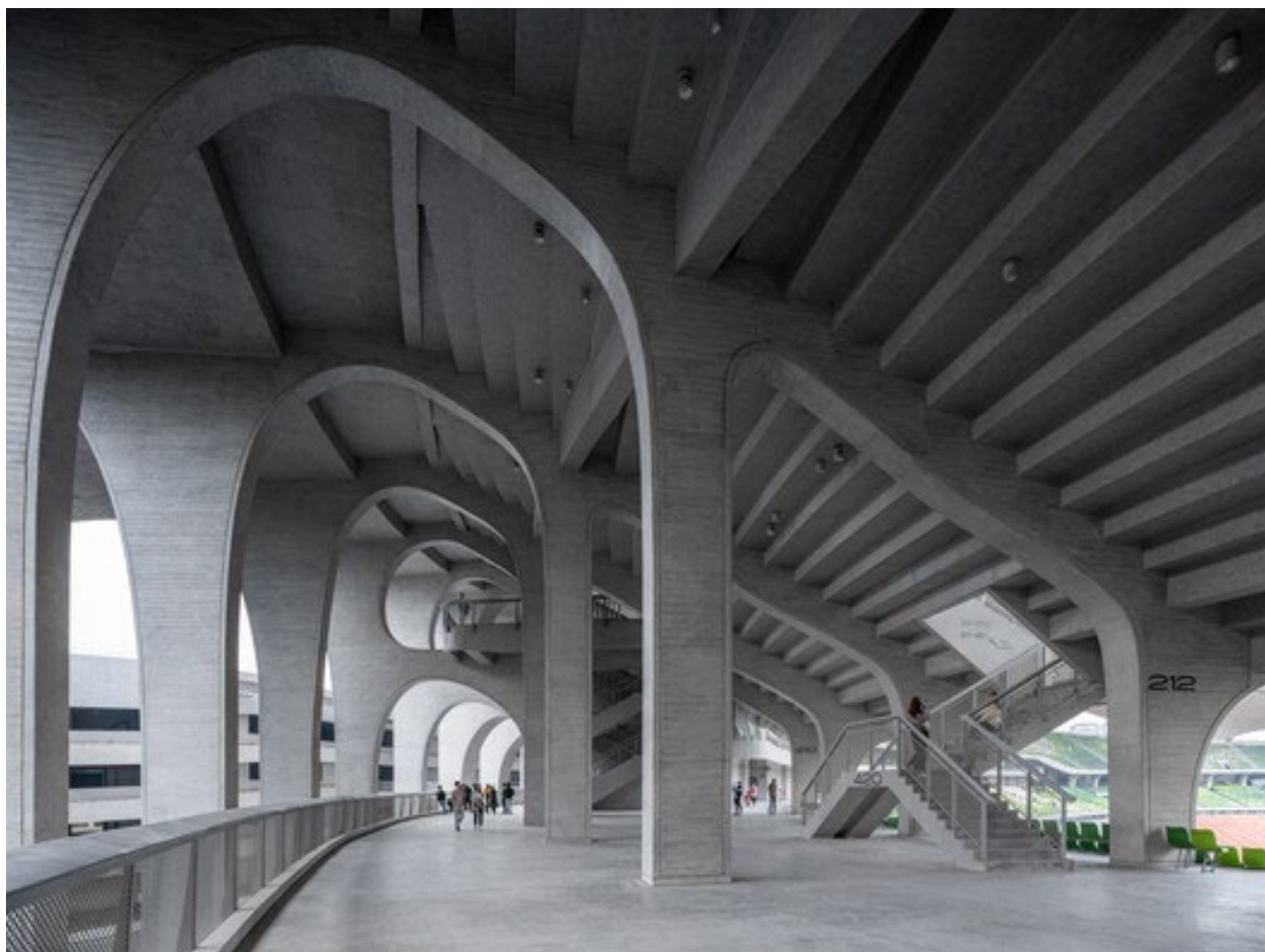
Рис.2.6.4. Бетонні рами під трибунами [25]
