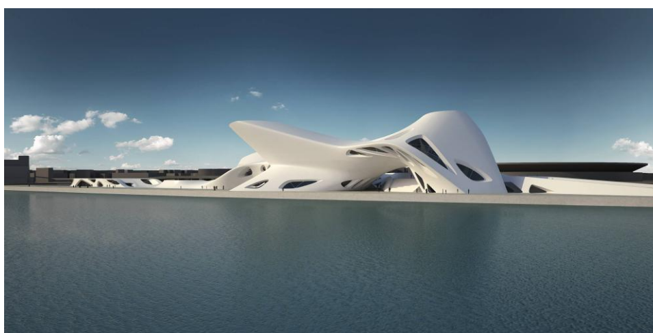
Рис 2.6.1. Екстер'єр будівлі музею середземноморського нурагічного та сучасного мистецтва [42]
