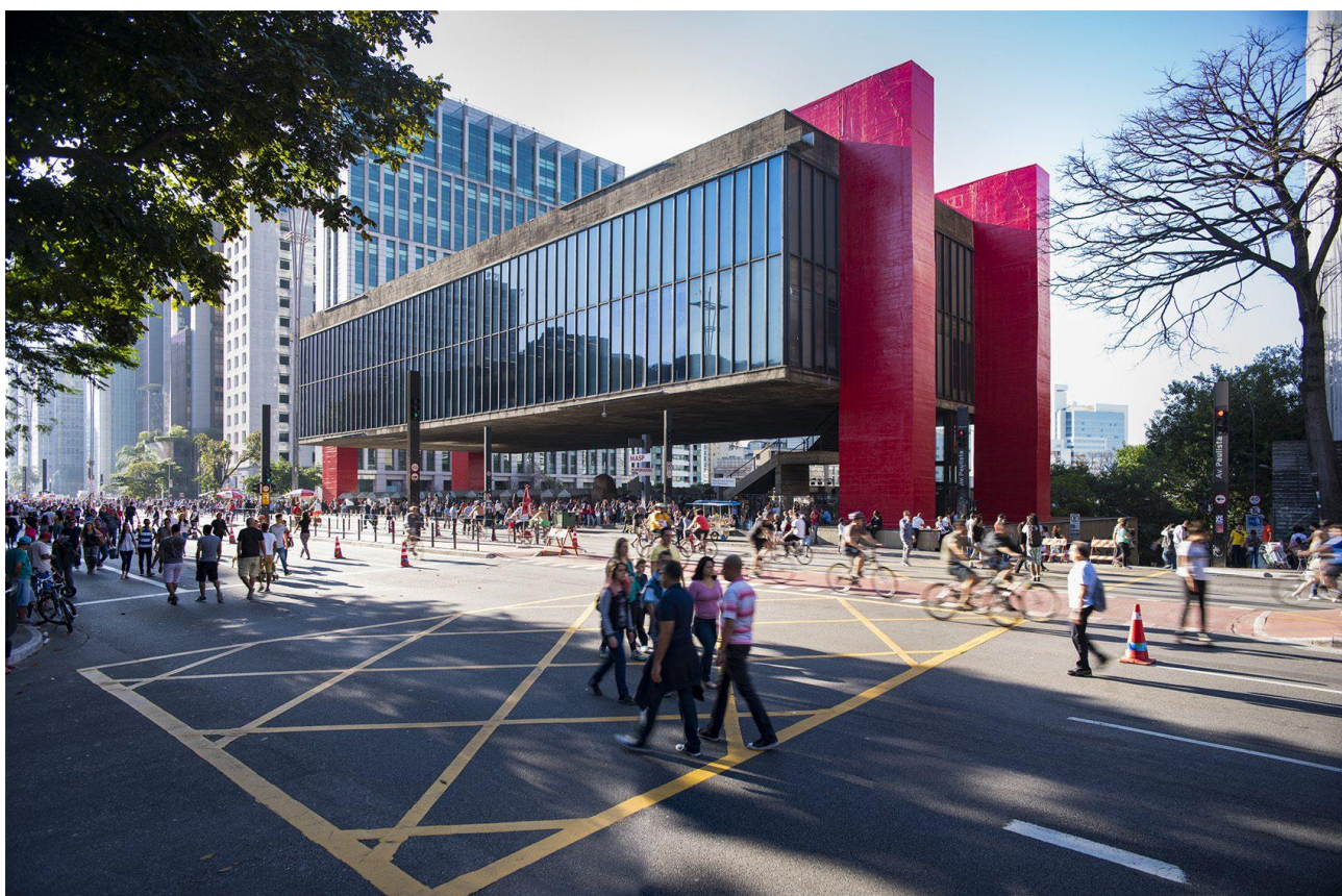
Рис 2.2.1. Екстер'єр будівлі Музею мистецтв Сан-Паулу [23]
