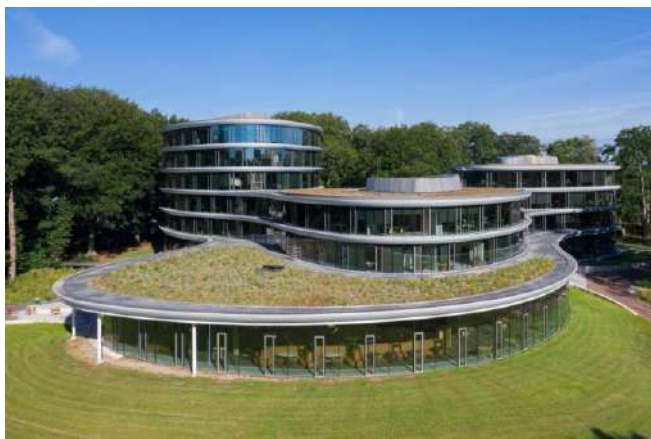
Рис.1.2.23. Загальний вигляд будівлі банку Triodos. Архітектор: RAU Architects. Дріберген-рйзенбург, Нідерланди, 2019 рік[23].
