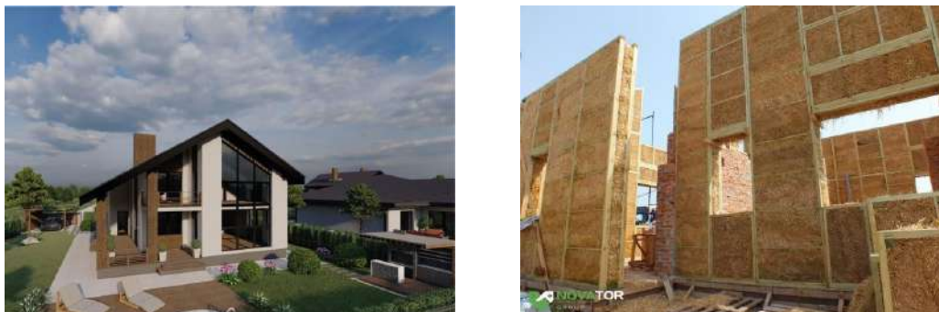
Рис.1.2.5. Будинок з солом'яних блоків. А-Вигляд під час будівництва. Б-Вигляд готового будинку[13].
