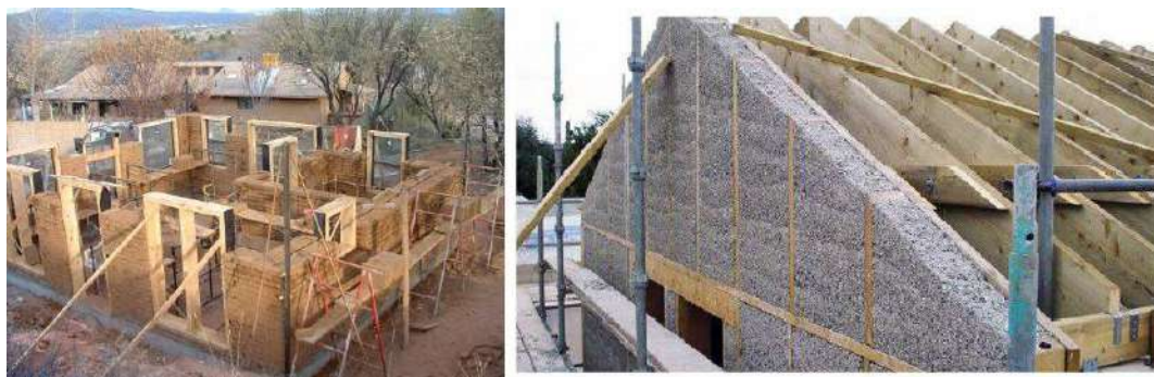
Рис. 1.1.3. Будівництво сучасних житлових будинків: а-з саман, б-з костри[75].
