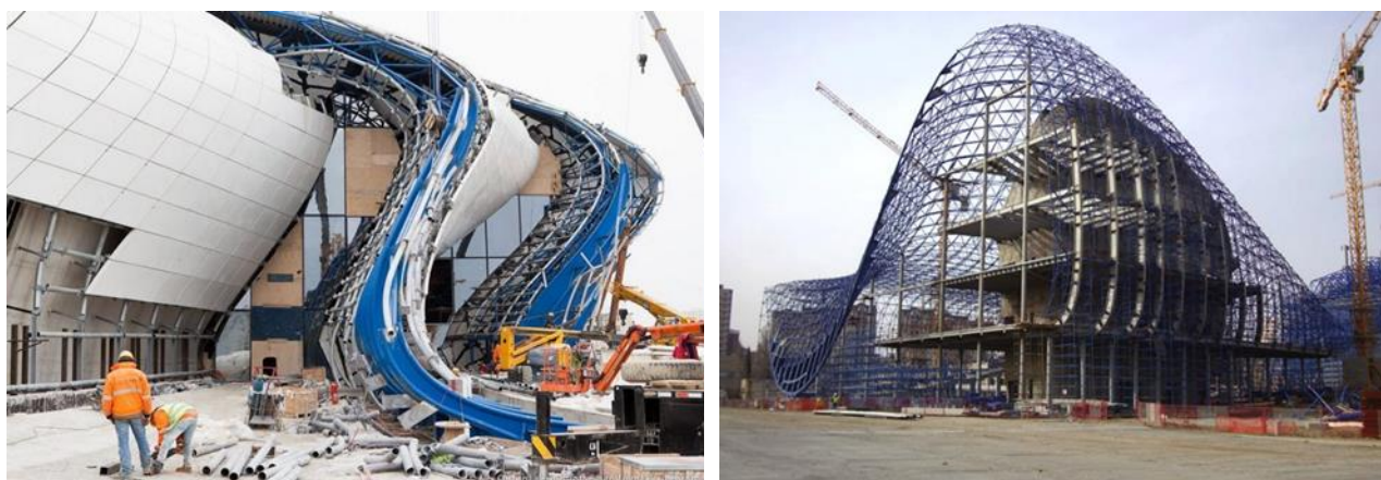
Рис. 2.13 Конструкційна система центру Гейдара Алієва
