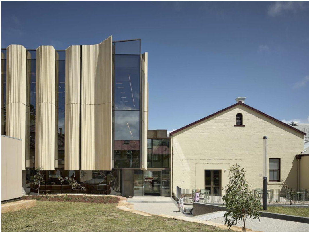
Рис. 2.13. Фасади бібліотеки Warrnambool Learning and Library Centre та історичної будівлі [13].
