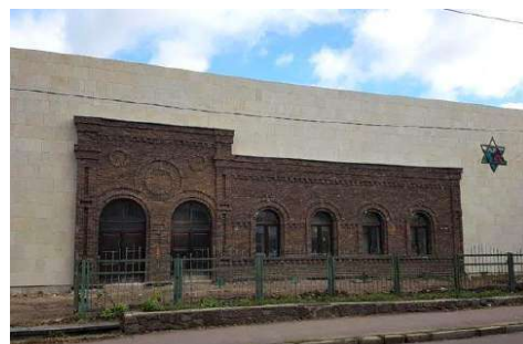
Рис 3.1.9.16. Синагога після реконструкції [36]
