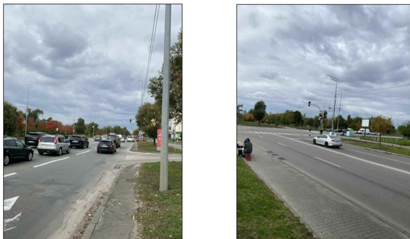
Рис.2.6 Фото вузла Дніпровська набережна – вул. Березняківська
