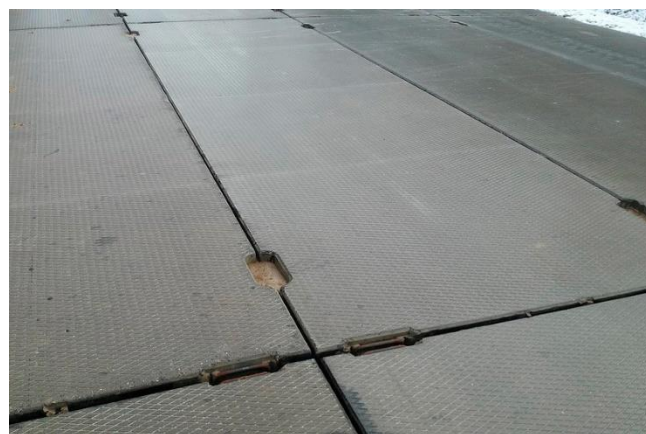
Рис. 1. Загальний вигляд плити аеродромного покриття
