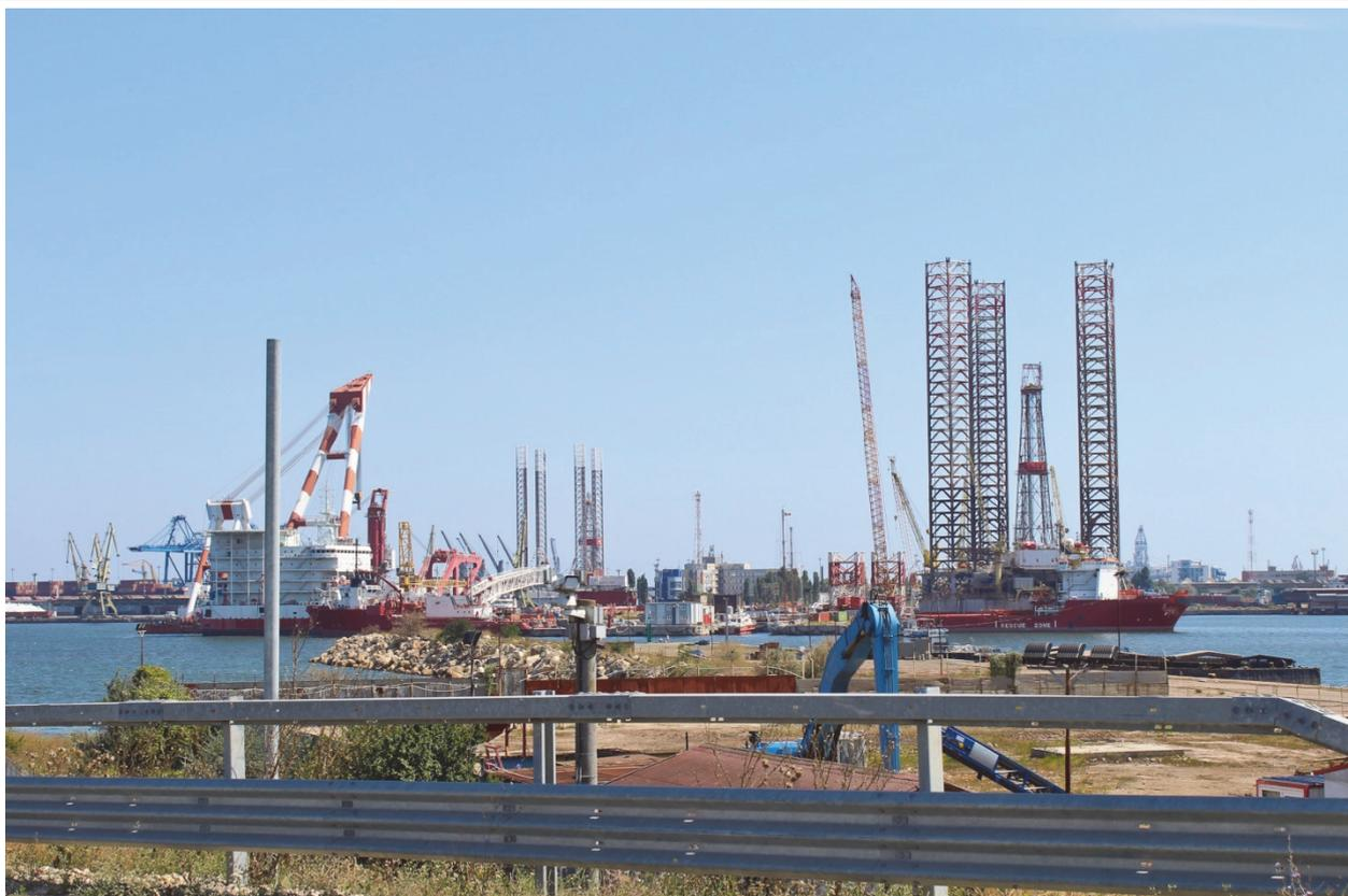
*Рис. 5. Сборка платформ для добычи газа на шельфе Черного моря. Фото автора*
