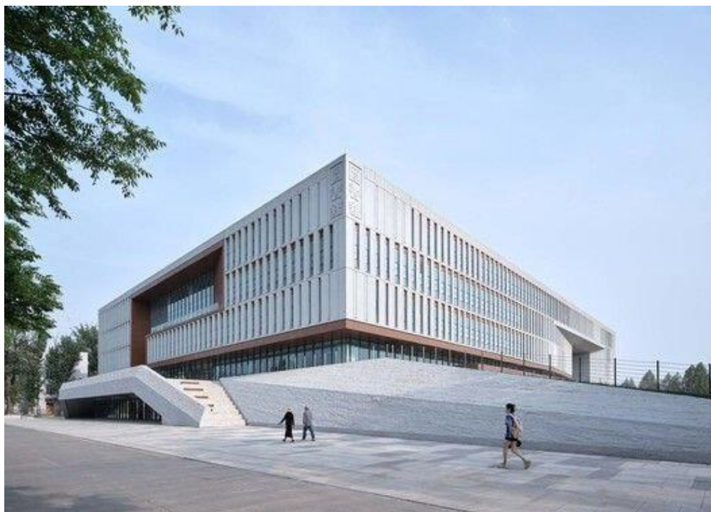
Рис. 2.10.1. North Campus Library, Northwest A&F University, архітектурне бюро SCUT - студія TaoZhi [15]
