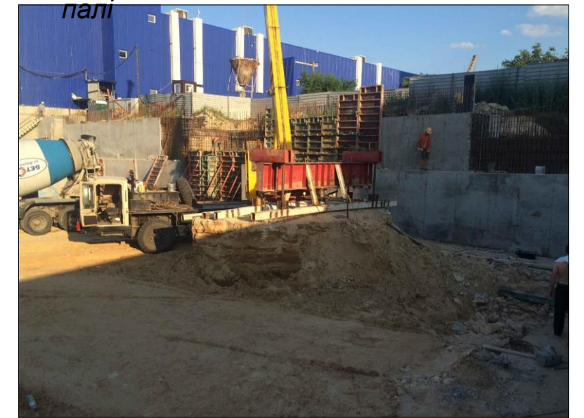
Випробовування ґрунтоцементної палі
