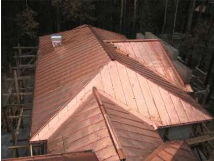
Рис. 138. Покрівля житлового будинку з мідних листів
