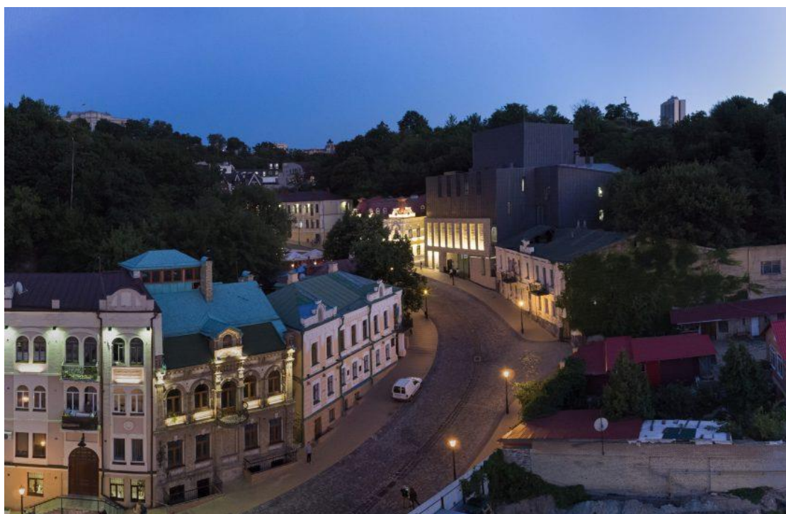
Рис. 2.11. Вигляд будівлі в комплексі із забудовою Андріївського узвозу [1]
