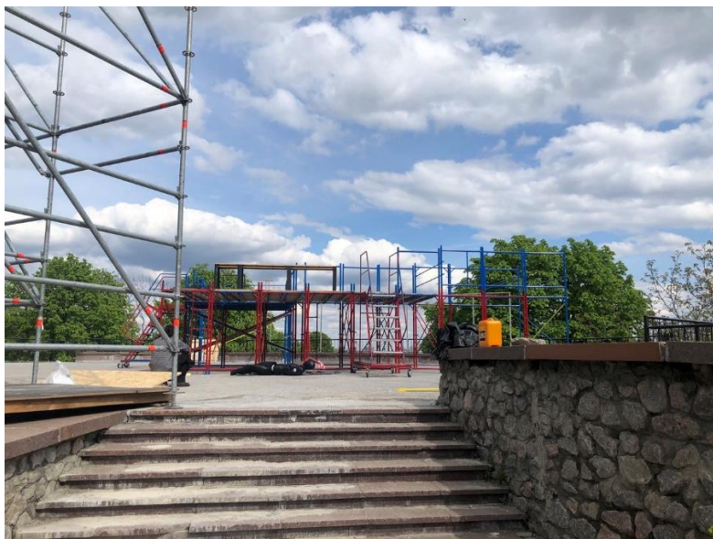
Рис. 4.4 Етап будівництва на Співочому полі
