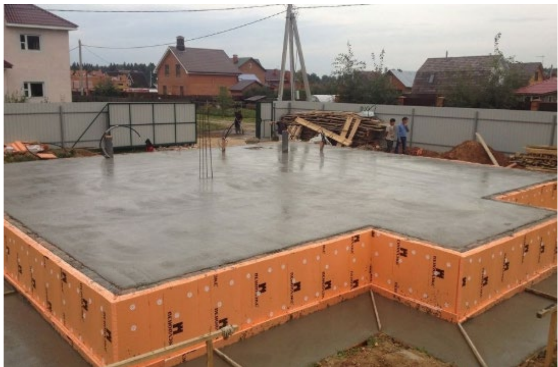
Рис. 6.3. Виготовлення монолітної фундаментної плити [24]
