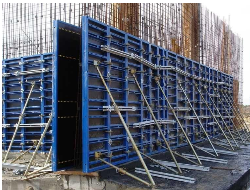
Рисунок 3.2.4 З'ємна опалубка для стін
