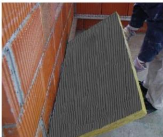
Рисунок 3.6.4 Перевірка якості нанесення клейкого матеріалу
