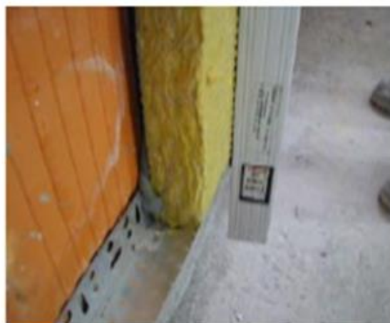
Рисунок 3.6.4 Перевірка якості нанесення клейкого матеріалу
