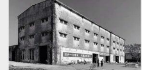
Частково знесена стара електростанція
