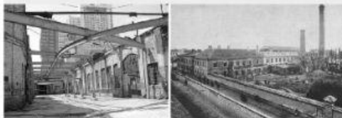
Фотофіксація фабрики Норбліна до реконструкції
