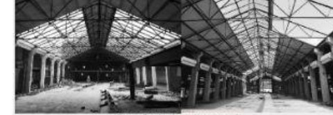
Стан будівлі до реновації
