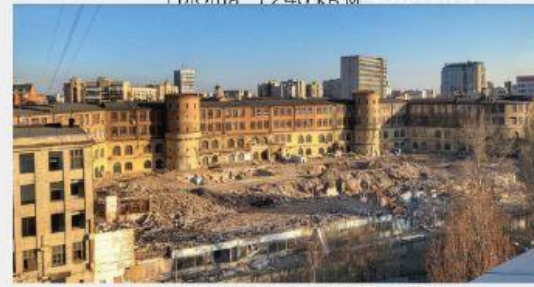
Стан будівель колишнього військового арсеналу в корпусі під номером 5, зведений наприкінці XVIII ст.
