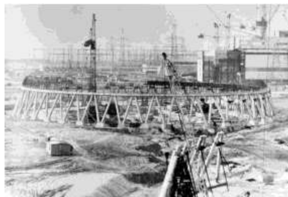
Рис. 3.1.2.14. Будівництво Рівненської АЕС, 1979 р. [45]
