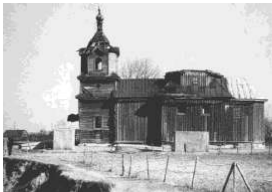
Рис. 3.1.2.23. Фото зруйнованої у 1979 році Варашська церква Арх. Махайла, Вараш, 1975 рік [39]
