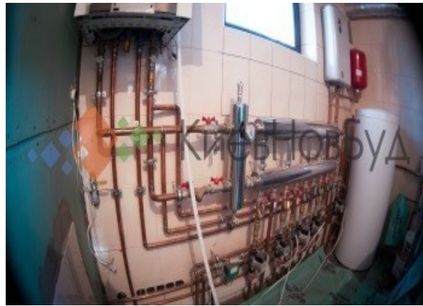
Рис. 2.2. Типове розташування теплового насосу, баку термоса
