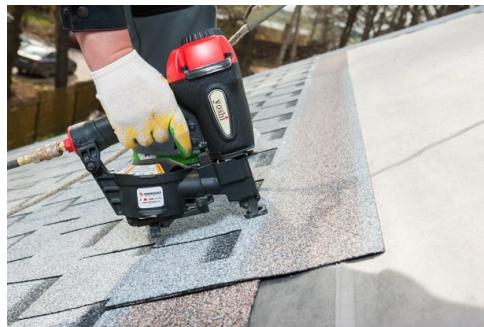
Рис. 3.13. Встановлення гнучкої покрівлі
