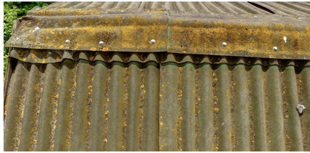
Рис.3.12. Приклад азбестової покрівлі
