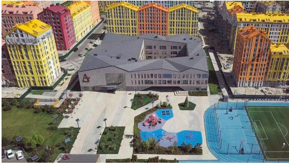
Рис 1. 3.13. Житловий комплекс Comfort Town Housing. Фото школи на території кмплексу [14]
