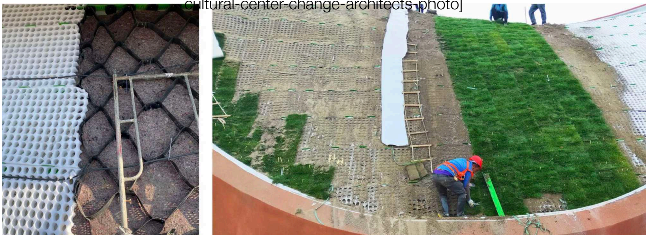
Вставновлення покрівлі даху (рис. ) [ https://www.archdaily.com/993815/chaohu-natural-and-cultural-center-change-architects?ad_source=search&ad_medium=projects_tab ]
