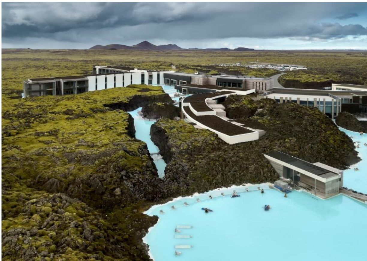
Рис. 2.9. Загальний вигляд комплексу [5]
