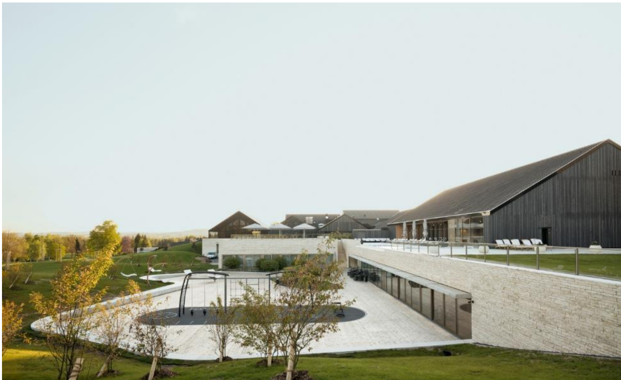
Рис. 2.10. Загальний вигляд комплексу [6]
