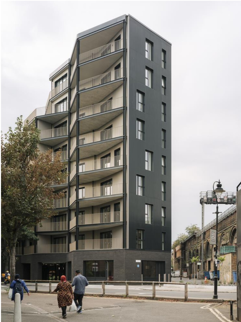
Рис. 2.2. Вигляд будівлі з торця [1]
