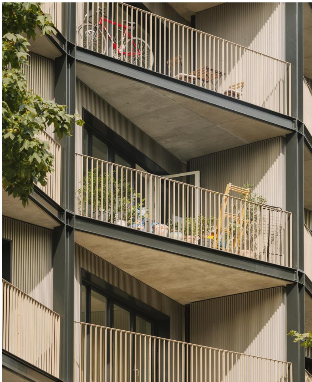
Рис. 2.4. Вигляд балконів будівлі [1]
