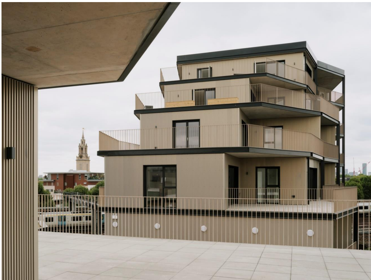
Рис. 2.5. Вигляд терас будівлі [1]
