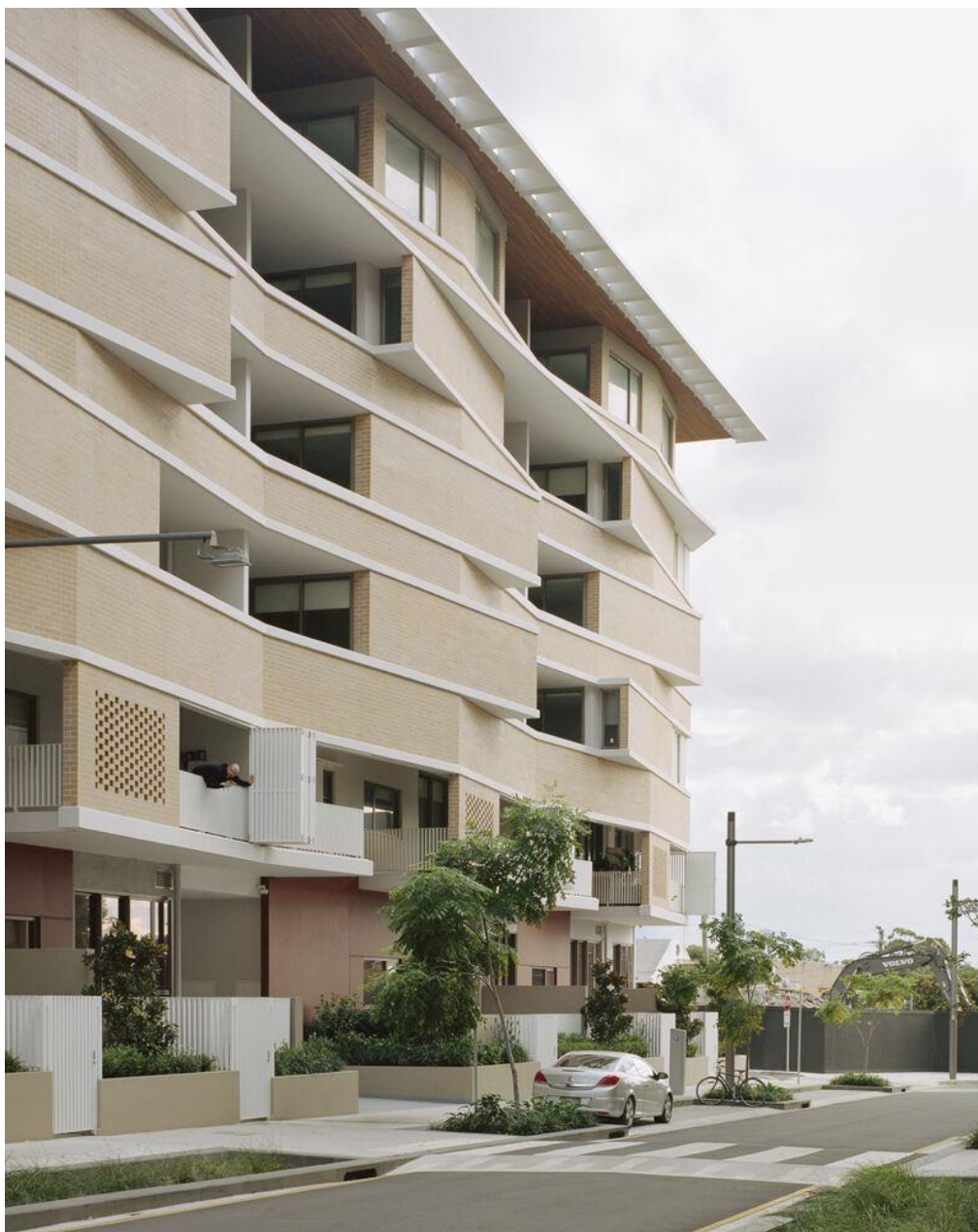
Рис. 2.13. Фрагмент фасаду будівлі [3]
