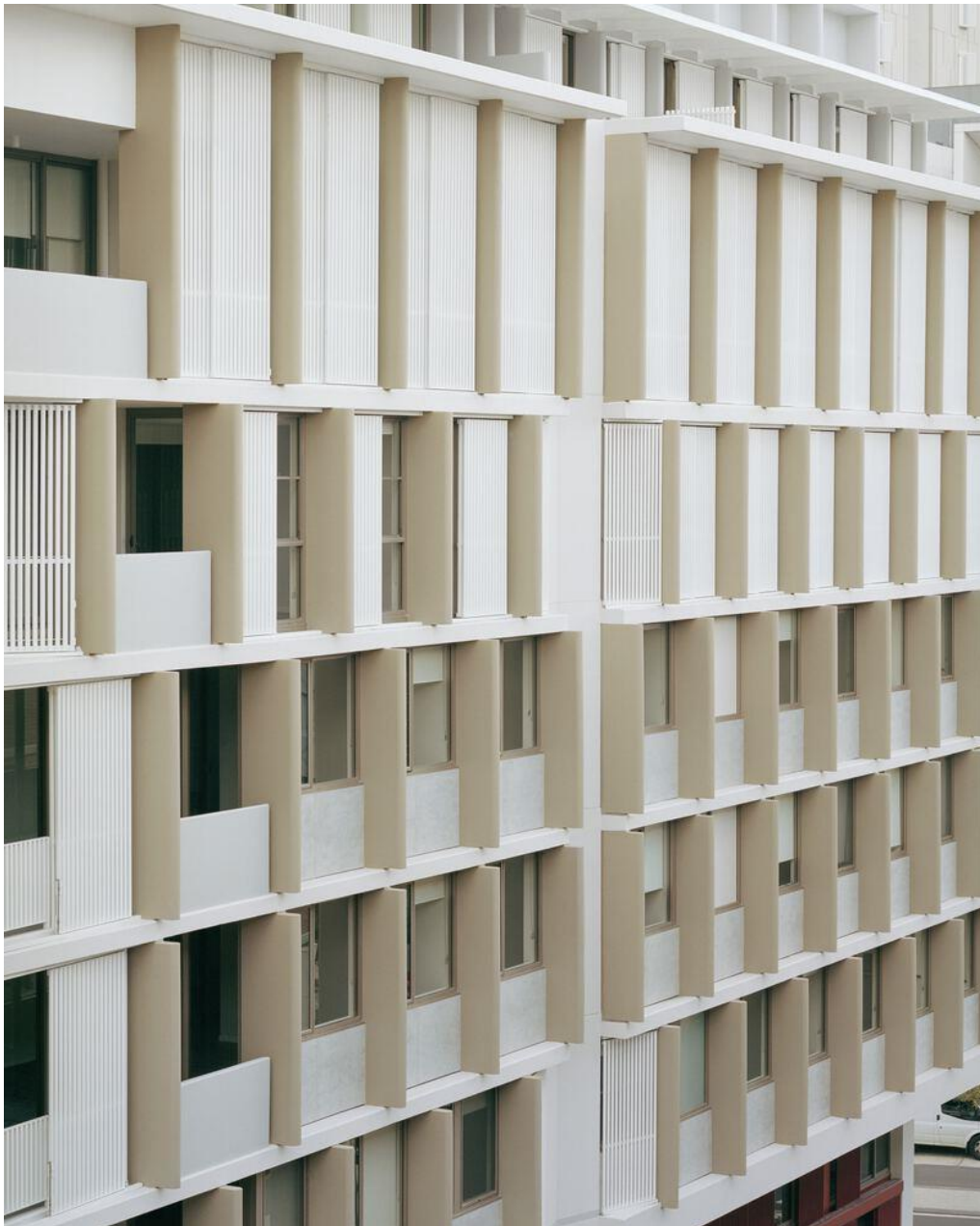
Рис. 2.12. Фрагмент фасаду будівлі [3]
