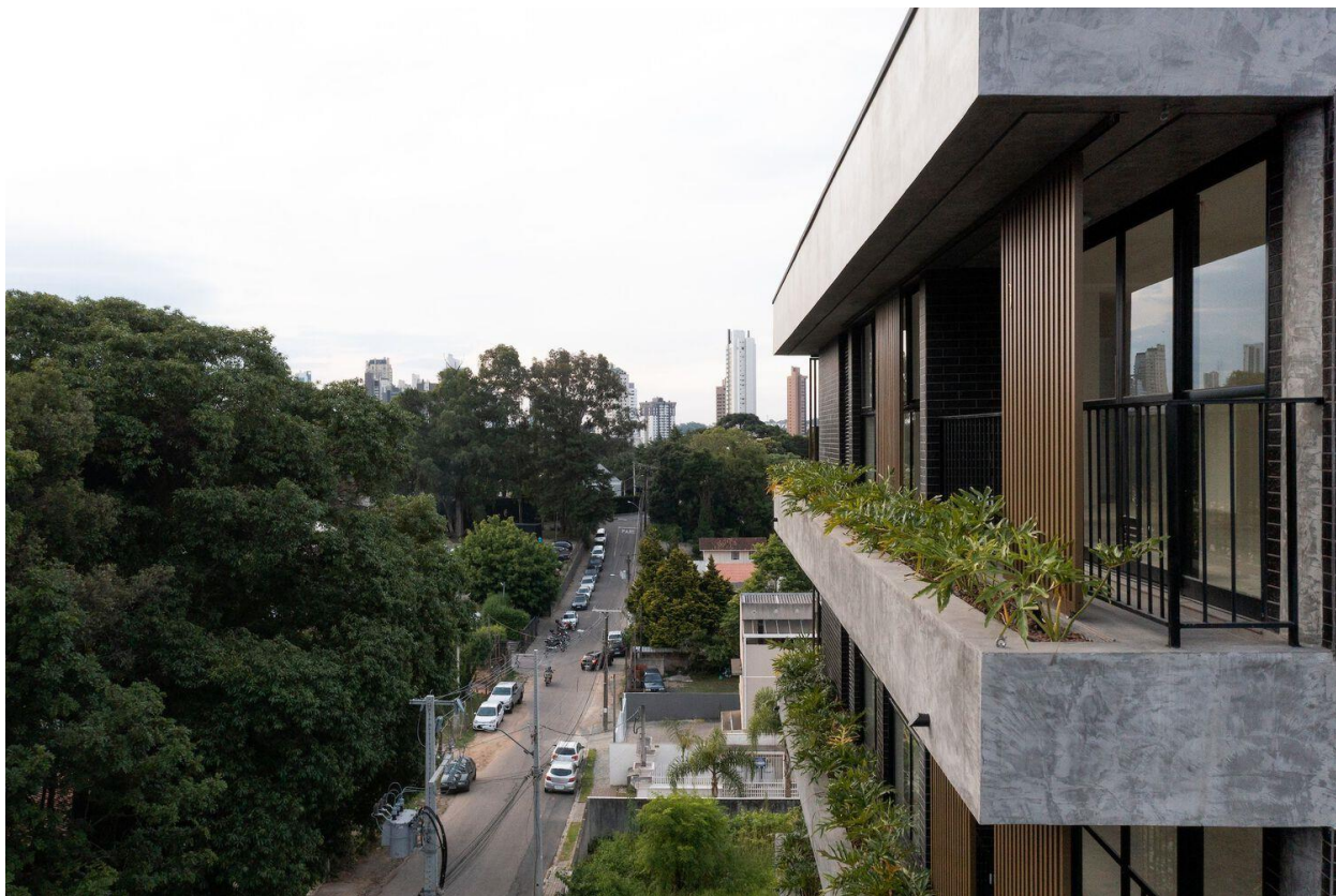
Рис. 2.9. Вигляд балконів будівлі [2]
