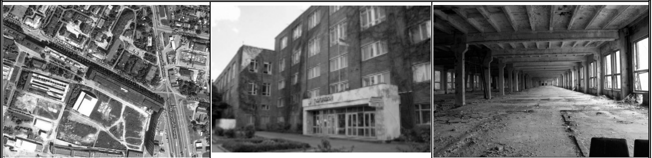
Рис. 2.1. Корпус заводу «Полярон» (вул. Угорська, 14)
