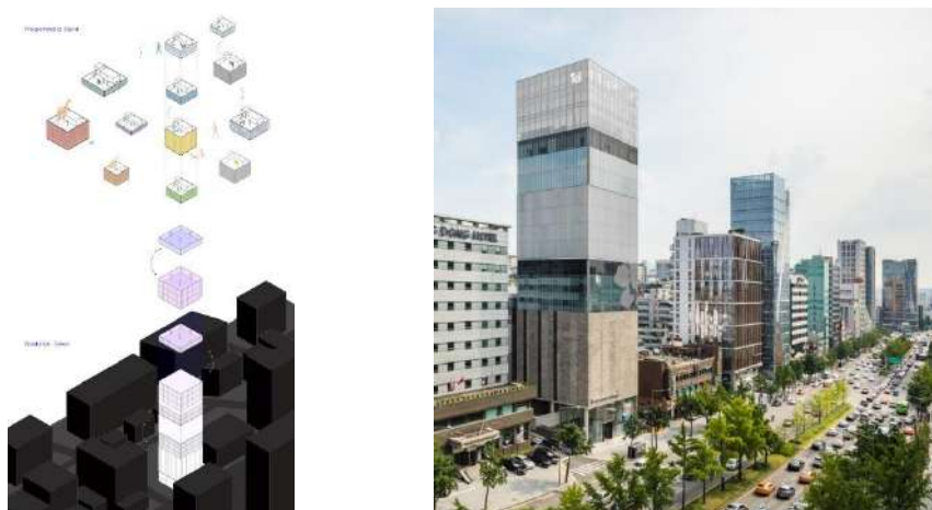
Рис. 2.1.7. ID лікарня, в Сеулі, Корея, 2015 р., архітектурне бюро Dongjin Kim + L'eau Design [57].
