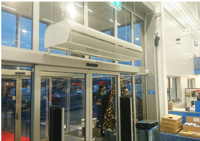
Рис.4.6. Теплова завіса з електронагрівом
