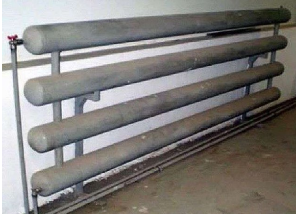
Рис. 4.11. Великий масивний реєстр, очевидним підвішений на двох потужних кронштейнах
