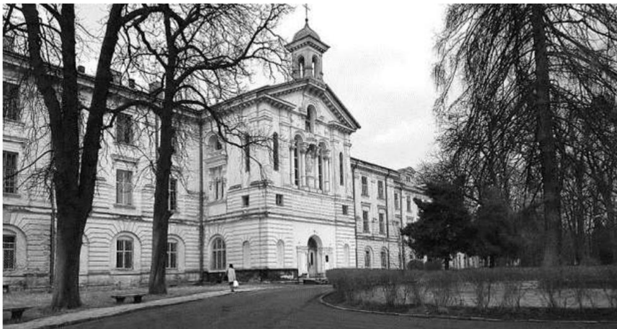
Рис. 1.3. Південний фасад з каплицею головного корпусу лікарні
