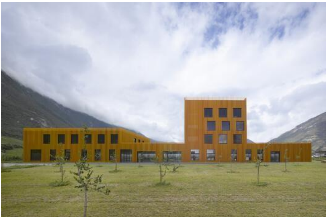
Рис. 2.1. Фото головного фасаду центру [12].
