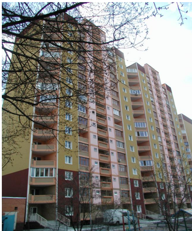
Рис. 2. Первый экспериментальный жилой дом серии АППС К-134 с тепловентилируемым фасадом в г.Киеве по ул.Тимошенко, 15
