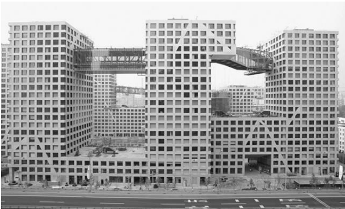
Багатофункціональний комплекс «Гібрид» у Пекіні. Архіт. Стівен Голл [Багатофункціональний комплекс «Linked Hybrid», Пекін, Китай [Електронне джерело]. 2009. ArchDaily. URL: https://www.archdaily.com/34302/linked-hybrid-steven-holl-architects ]
