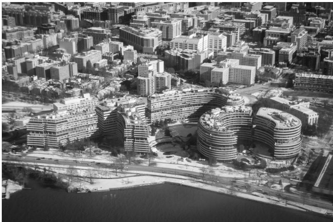
Житловий комплекс «Вотергейт» у Вашингтоні. Архіт. Луїджі Моретті [The Architect's Newspaper. Fifty Years of Watergate.[Електронне джерело]. URL: https://www.archpaper.com/2015/11/fifty-years-of-watergate/ ]
