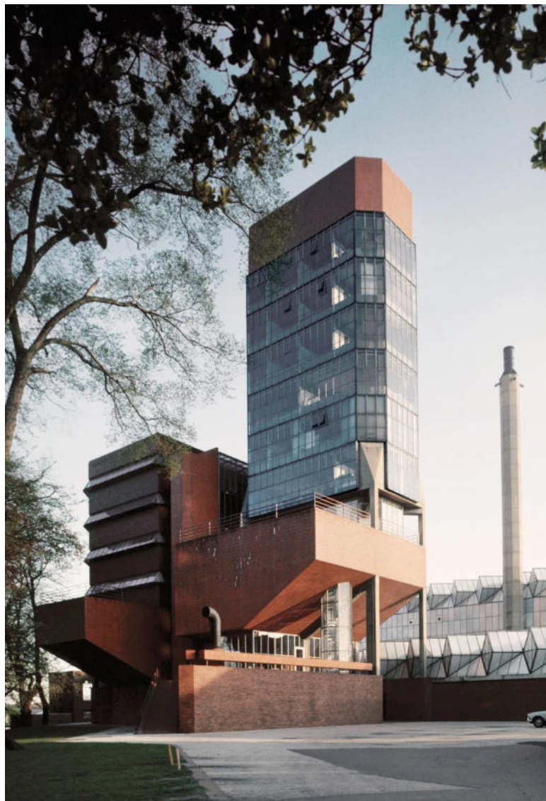
Рис. 1.3.14. Інженерний корпус Лестерського університету, Англія, 1959–1963. Архіт. Джеймс Стірлінг [The Leicester Engineering Building: James Stirling & James Gowan Masterpiece [Електронне джерело] Archeyes.– URL: https://archeyes.com/engineering-building-leicester-james-stirling-james-gowan/ ]
