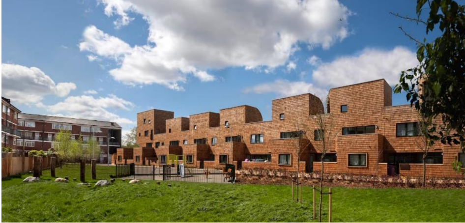
Рис. 2.24. - Таунхаус «Hannibal Road Gardens» by Peter Barber Architects, London, United Kingdom
