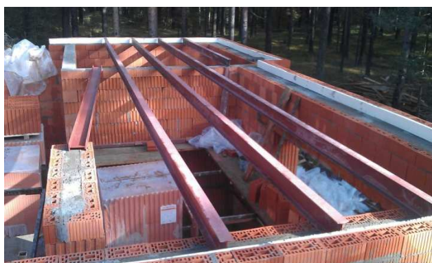
Рис. 5.1. Проста схема балочної клітини
