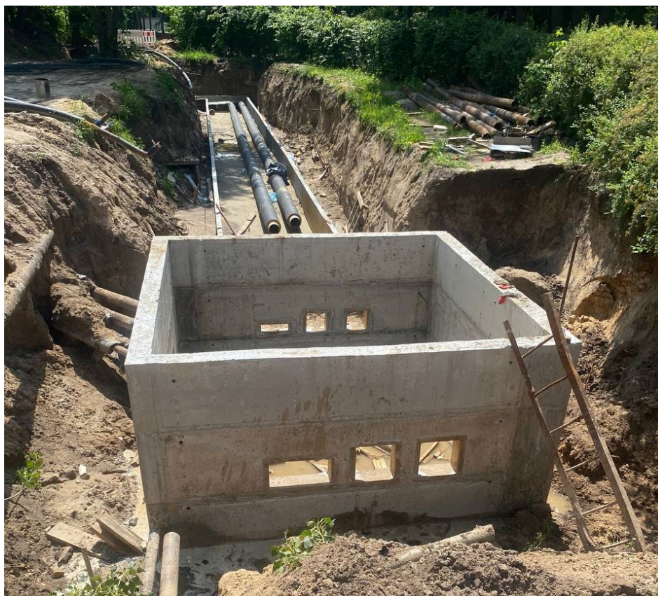
Рис. 2.4.5. Зображення ТК 3 після зняття опалубки
