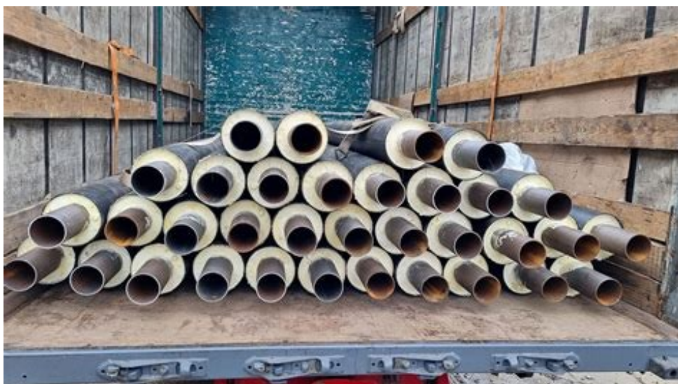
Рис. 3.1.2. Монтажні секції теплоізолюваних труб теплової мережі перед укладанням у траншею.
